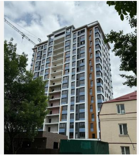
Рис. 1. Отделка фасадов многоэтажных домов композитными панелями
