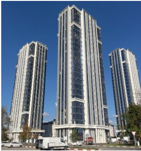
Рис. 1. Отделка фасадов многоэтажных домов композитными панелями
