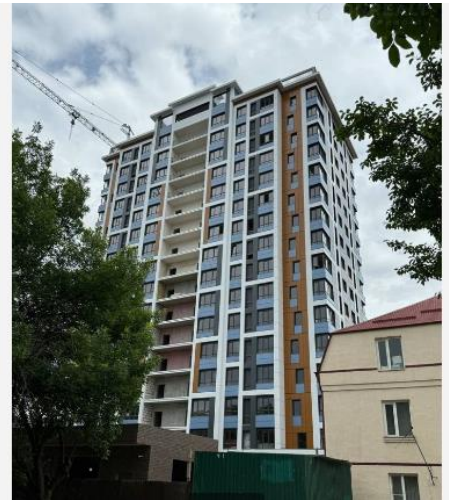
Рис. 1. Отделка фасадов многоэтажных домов композитными панелями
