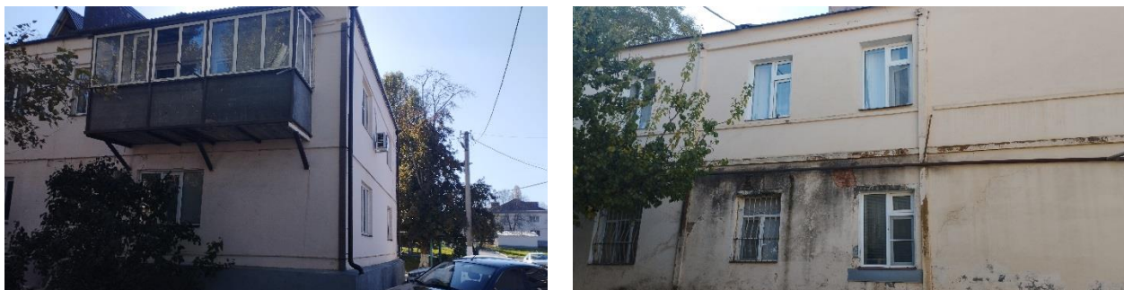
Рис. 2. Металлические скобы на фасадах жилых домов
